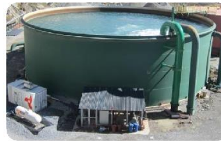
Tanques de agua procesada
