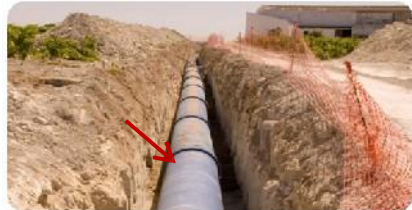
Tubería de conducción
