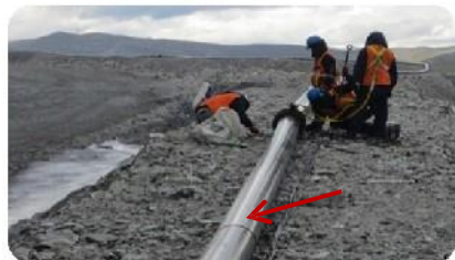
Instalación de hidrantes
